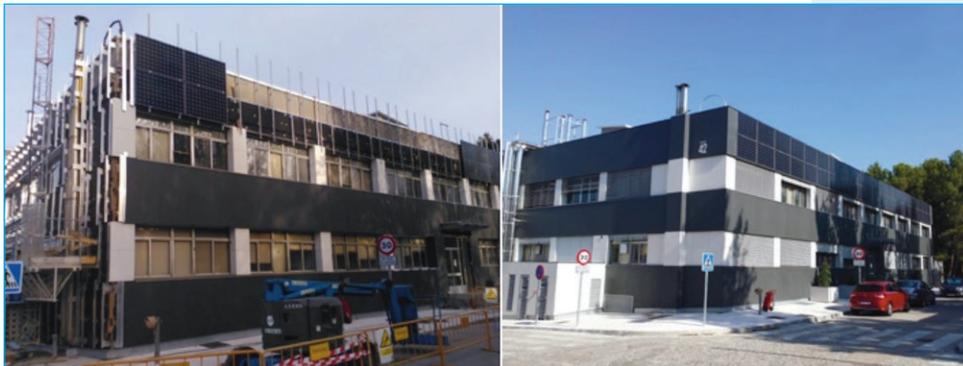
Figuras 1 y 2. Fase de montaje de los módulos fotovoltaicos en la fachada este y vista sureste del edificio tras la rehabilitación.
