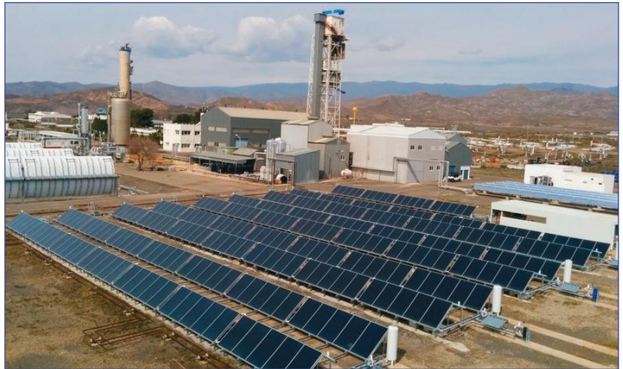
Campos de captadores solares estáticos de placa plana y gran formato para procesos térmicos de desalación de baja temperatura.
